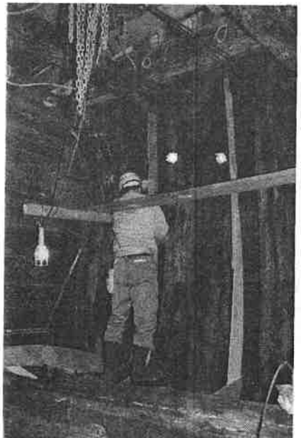
肋骨は一本一本型どりし、新材で補強する。カーブがあるため一枚板で出来ず、何枚もつなぎ合せて型材を作る。
