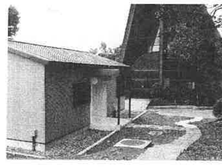
新しく完成した展示館の事務所・倉庫
