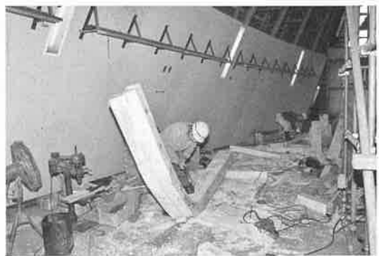
肋骨を仮組みする横川棟梁
