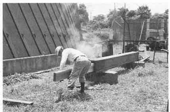
新しい外板を曲げるために蒸す
