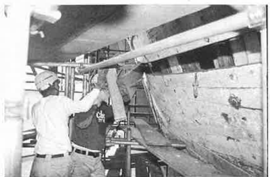
蒸した板を外に曲げながらつける
