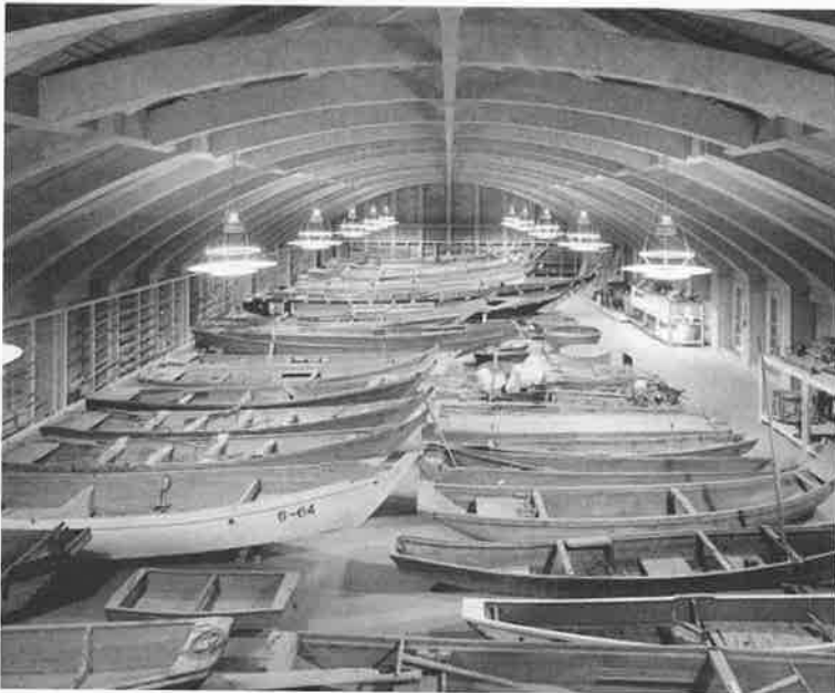
海の博物館の収蔵庫「舟の棟」。独特のドーム型の建物で木造船多数を収納。湿気をもたせるため床面は、土である。海の博物館の設計は内藤廣氏で日本建築学芸賞を受賞。収蔵資料は55,000点で6,800点余が国指定の重要有形文化財。撮影・小林浩志
