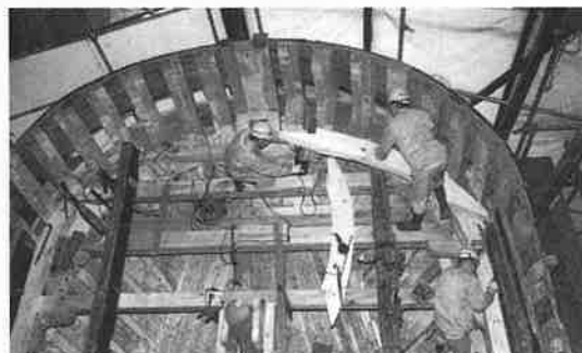
船尾部補修 船鰐の取付け作業
