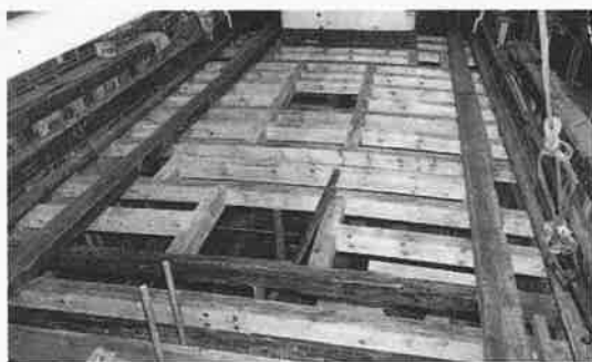
上甲板・梁補修 上甲板梁の取替え
