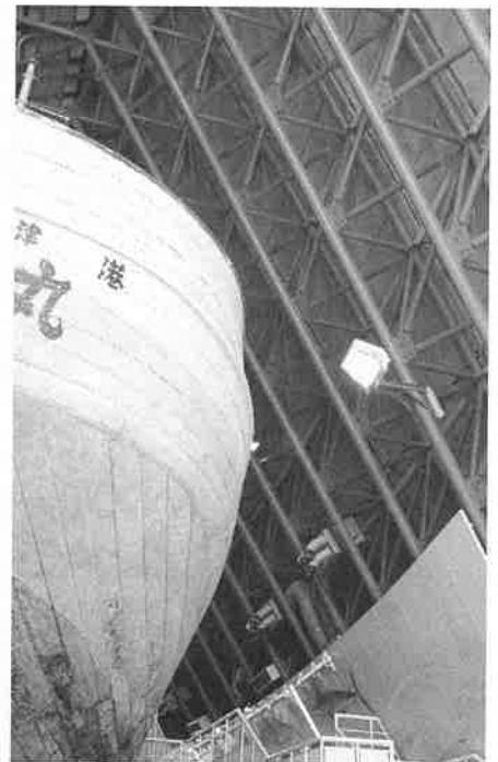
展示館内。写真右の鉄骨の柱をおおう壁は途中までしかない
