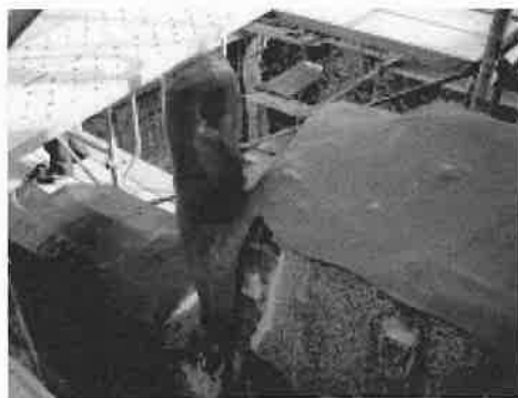
保存工事の施行
