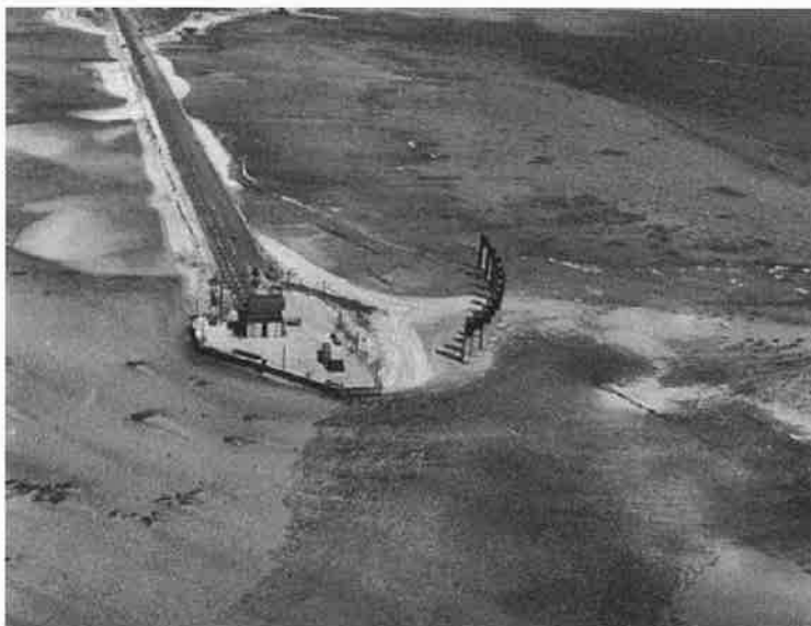
【ビキニ環礁 水爆ブラボーを据え付けた台座】 環礁の一つナム島の沖合のさんご礁の浅瀬にコンクリートで台を作り50メートルの鉄塔を建て、その上に水爆を設置した。米軍資料より、提供・豊崎博光
