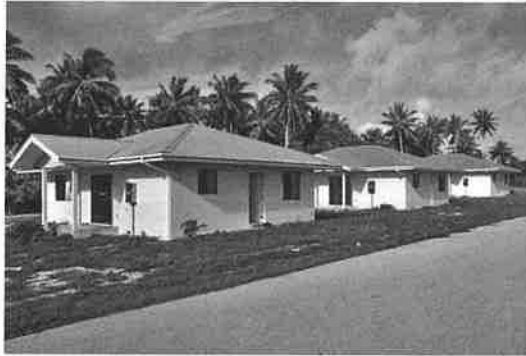
建築が進む帰島民用の50戸の新住宅（ロンゲラップ本島）
