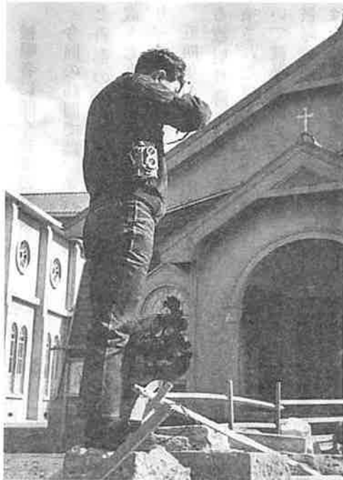
原爆で破壊された爆心地に近い浦上天主堂で撮影する東松さん。筆者撮影
