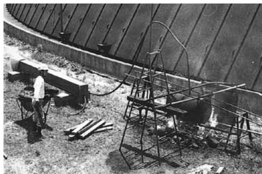
一九八五年福竜丸補修工事での蒸曲げの様子
